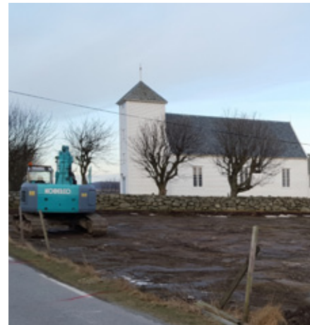
Bilde over: Utviding av parkeringsplass.
